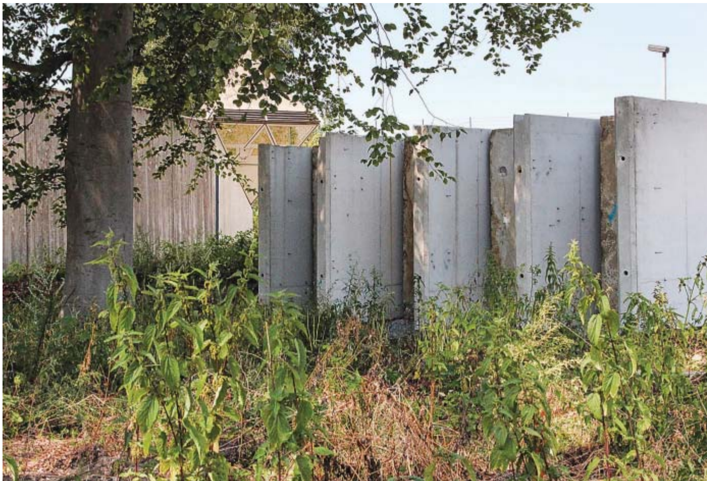
Lagerplatz: Bis die Mauerteile für die Erweiterung gebraucht werden, warten sie auf dem zukünftigen Bauplatz neben der Gefängnismauer (links) auf ihren Einsatz. Die Beamten haben von der Kanzel (hier ein wenig hinter dem Baum versteckt) den Überblick. FOTO: JUDITH GLADOW
