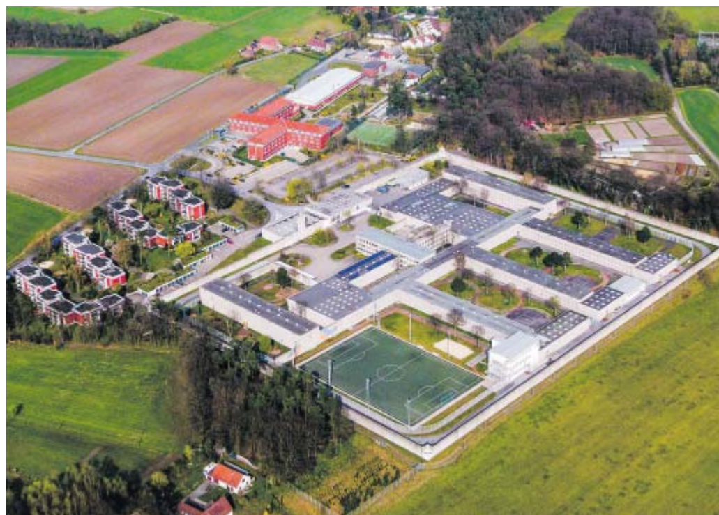
Umringt von 850 Meter Mauerwerk: Die JVA Brackwede ist gut 10 Hektar groß und besteht aus sieben Hafthäusern und zwei Krankenpflegestationen. Das rot geklinkerte Haus im Hintergrund ist das Hafthaus Ummeln (offener Vollzug, früher: JVA Brackwede II). Links liegen die Bedienstetenwohnungen, hinten rechts im Bereich der JVA-Gärtnerei könnte bald das achte Hafthaus entstehen.
