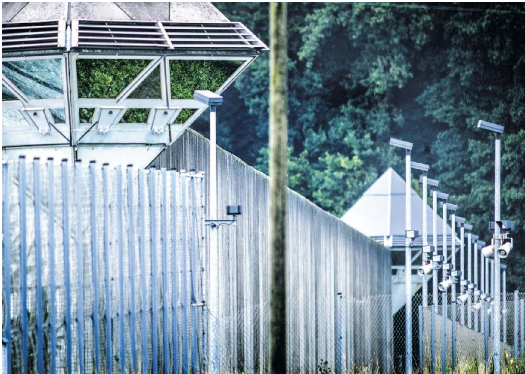
40 Jahre alt: Die Haftanstalt verfügte ursprünglich über runde Mauerabschlüsse. Als 1979 bis 1982 die Terroristenabteilung (heute: Hochsicherheitstrakt) mit den prägnanten, oktaedrischen Beobachtungskanzeln entstand, mussten die Mauern wieder kantig werden.
